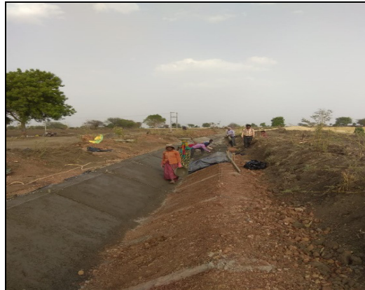
स्लीपरों और न्यून-घनत्व पॉलीएथिलीन फिल्म की ढलाई को दर्शाने वाला नमूना-चित्र
